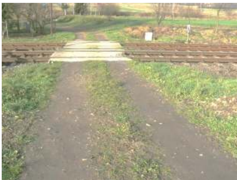
Fot. 4 Końcowy odcinek drogi przed torami kolejowymi
