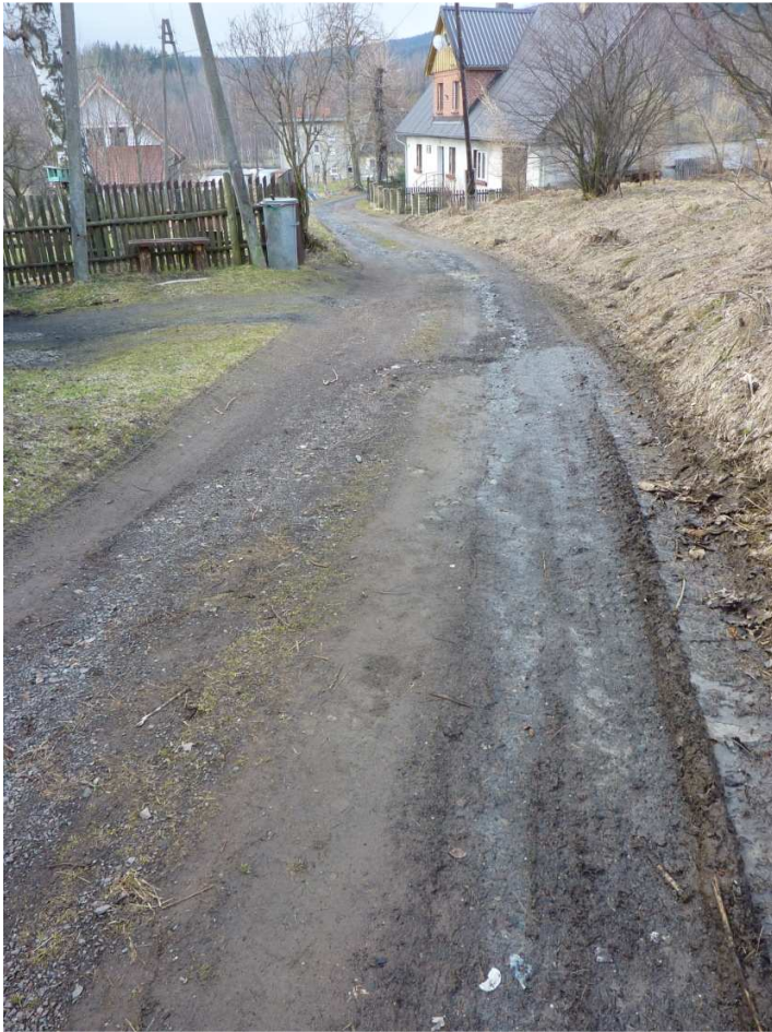
Fot. 3 Stan istniejący remontowanej drogi
