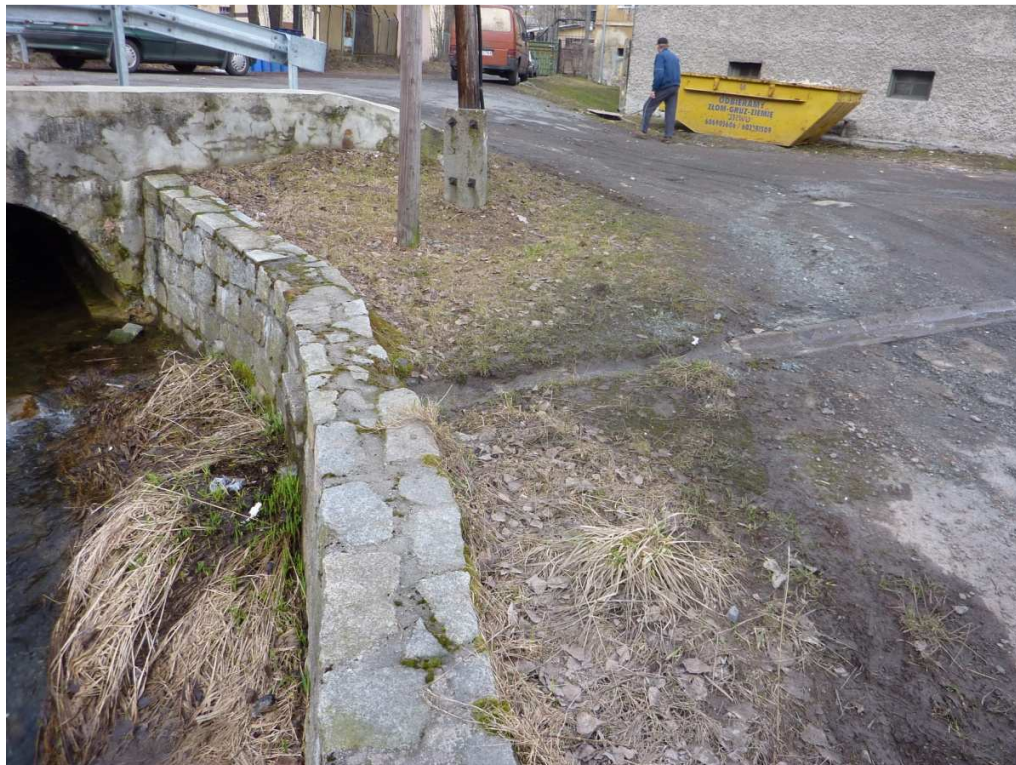
Fot. 1 Widok włączenia do drogi gminnej
