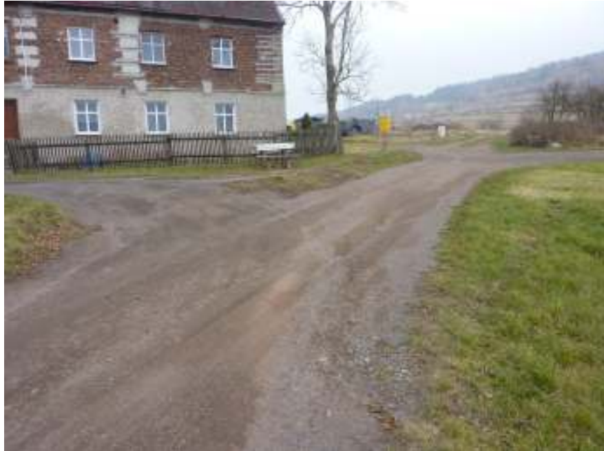
Fotografia 6 - Odcinek przebudowy drogi na działce nr 472/11
