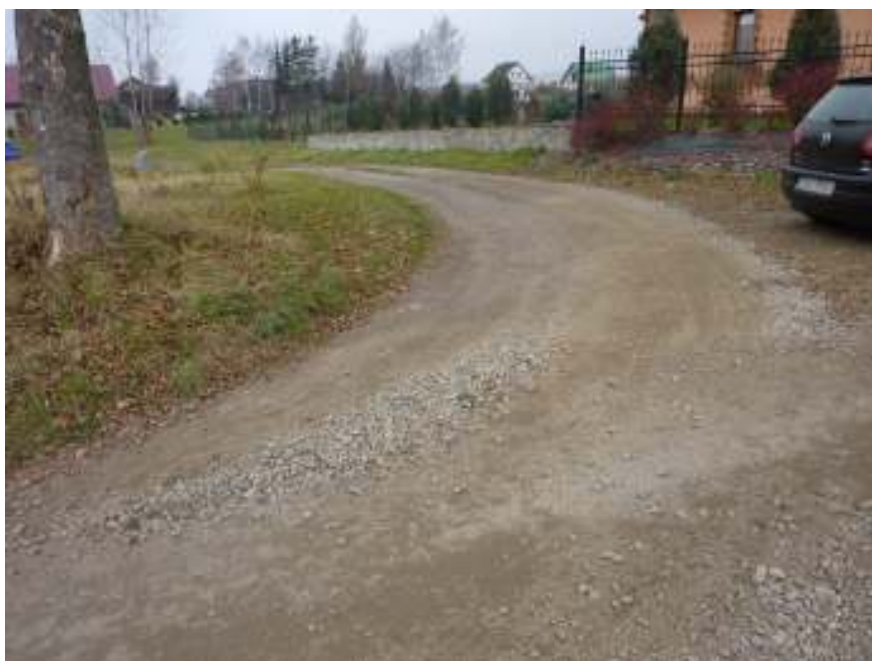
Fotografia 4 - Fragment drogi na działce nr 472/26
