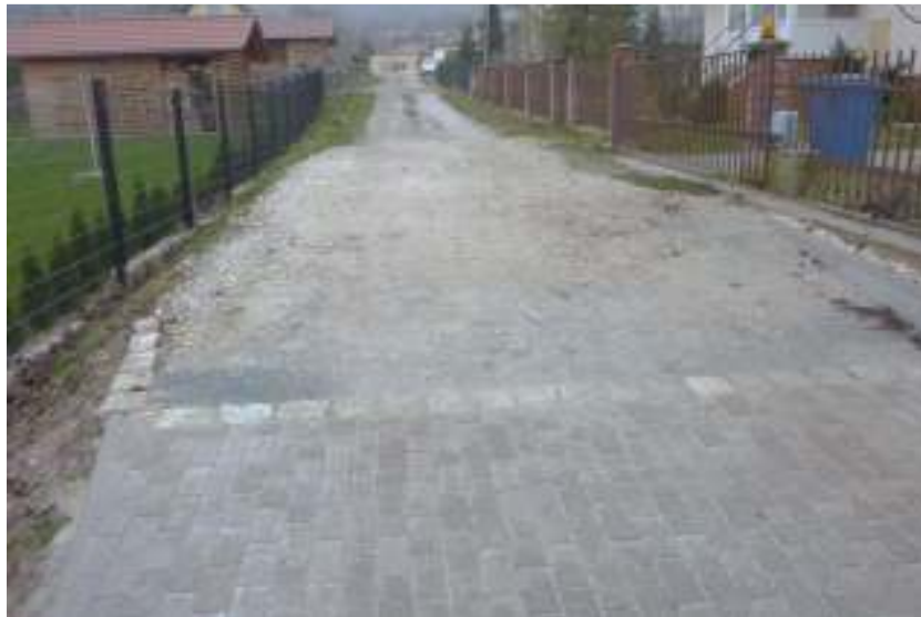
Fotografia 1. Początek opracowania – odcinek A-B, km 0+000,00.
