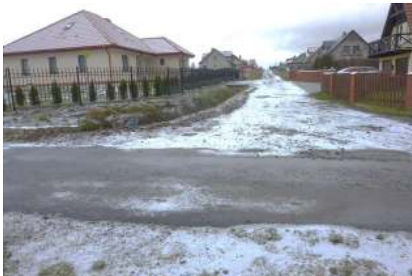
Fotografia 1- Początek opracowania km 0+000,00 – włączenie do ul. Kalwaria. Widoczny lewostronny rów przydrożny.
