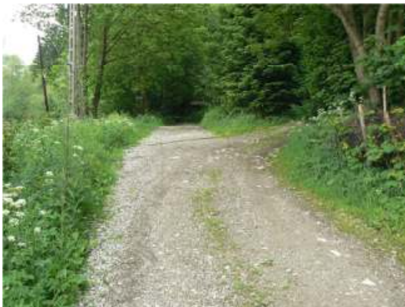
Fotografia 2. Ogólny stan nawierzchni w części środkowej.
